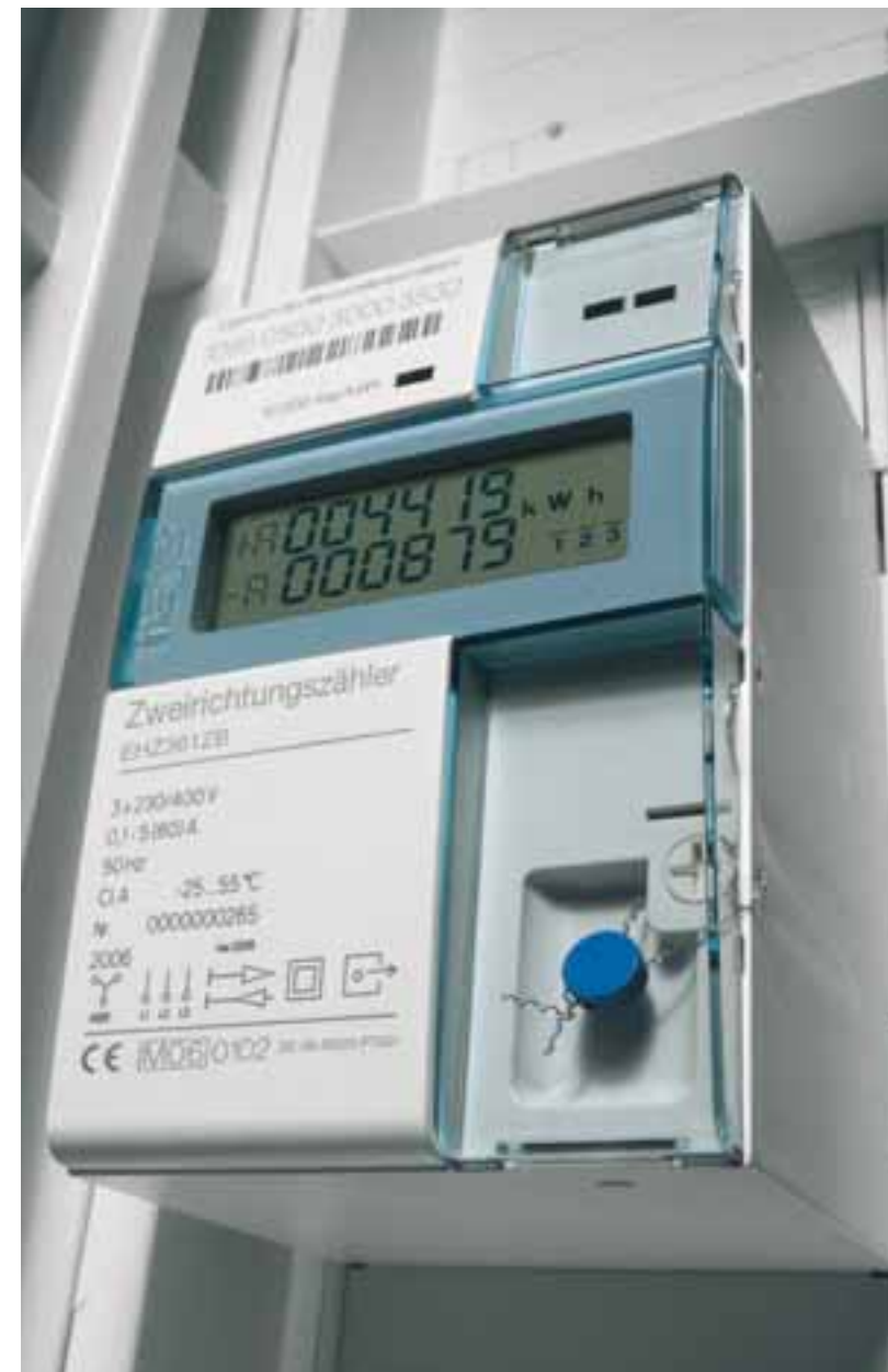
Der elektronische Haushaltszähler wird ab 2020 in jedem Haus Europas Standard sein. Bereits heute ist das Gerät Pflicht für alle Neubauten und überzeugt seine Besitzer durch zahlreiche Vorteile gegenüber den klassischen Stromzählern. Foto: Hager
